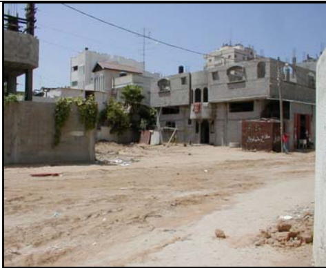
صورة رقم 7: المبنى متعدي بالطاير على أرض الجار الفضاء
