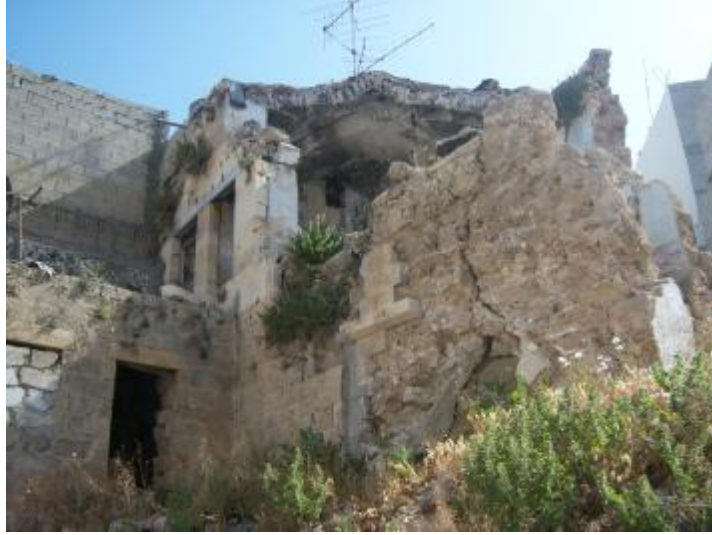
شكل (4) هدم البيوت الأثرية، (المصدر: الباحث)
