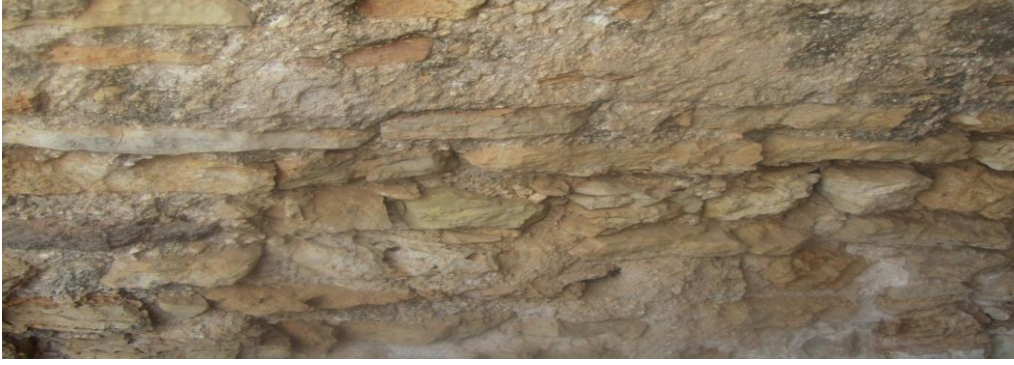
تصوير الباحثين (سقف أحد الأقبية التي توجد داخل القلعة)
